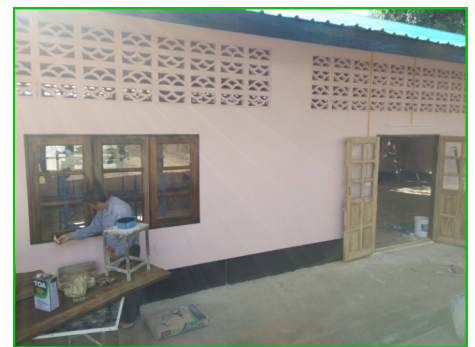
窓ガラスも入り間もなく完成です
