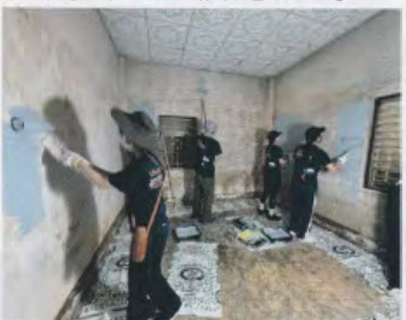
ボランティアとスタッフの復旧作業
